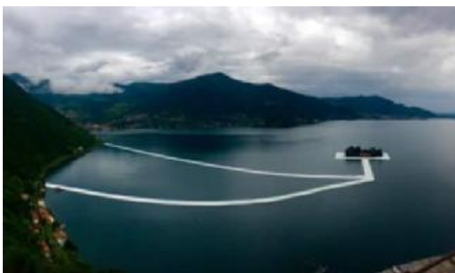
Il «miracolo» del ponte di Christo sta prendendo sempre più forma
